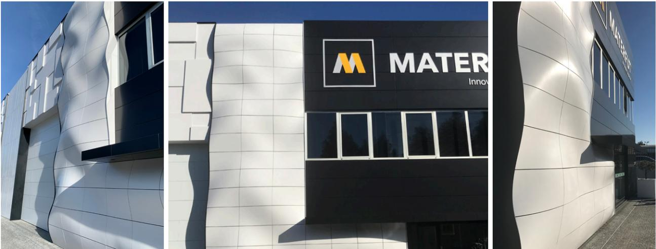
Una nuova tecnologia per creare, risparmiando tempo e riducendo risorse e impatto ambientale, soluzioni di rivestimento esterno ed interno con geometrie e strutture complesse, curve e forme irregolari (foto: progetto di rivestimento esterno per l'edificio di Materfut® in Portogallo).
